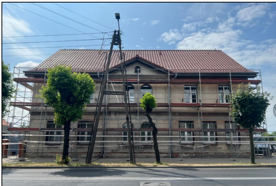
Rysunek 29 Budynek Urzędu Gminy w Czempiniu w trakcie termomodernizacji.
