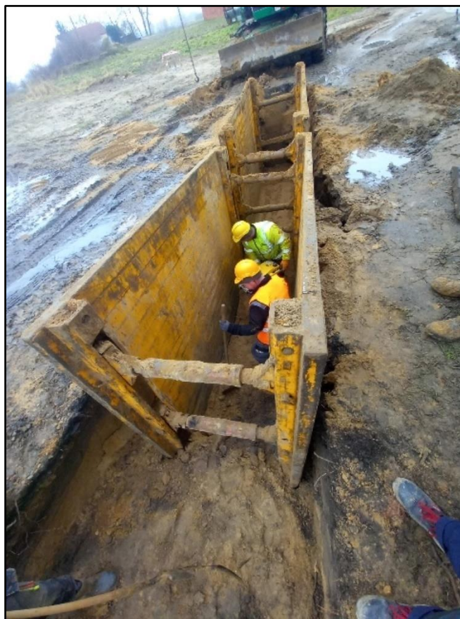
Rysunek 25 Budowa sieci kanalizacji sanitarnej i wodociągowej Nowe Borówko
