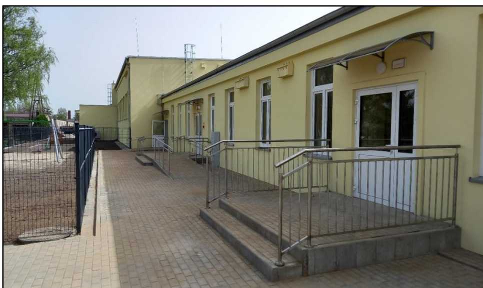
Rysunek 30 Sala gimnastyczna z zapleczem w Starym Gołębinie
