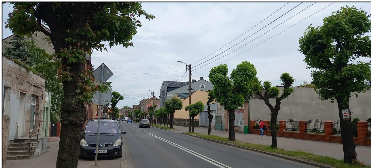
Rysunek 18 Wymiana opraw oświetleniowych
