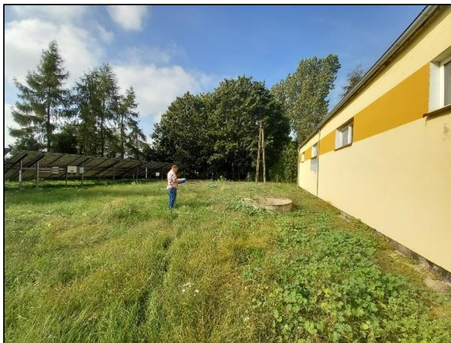
Rysunek 28 Stacja uzdatniania wody w Gorzyczkach
