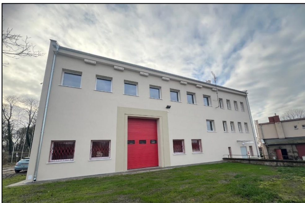
Rysunek 22 Budynek Ochotniczej Straży Pożarnej w Czempiniu
